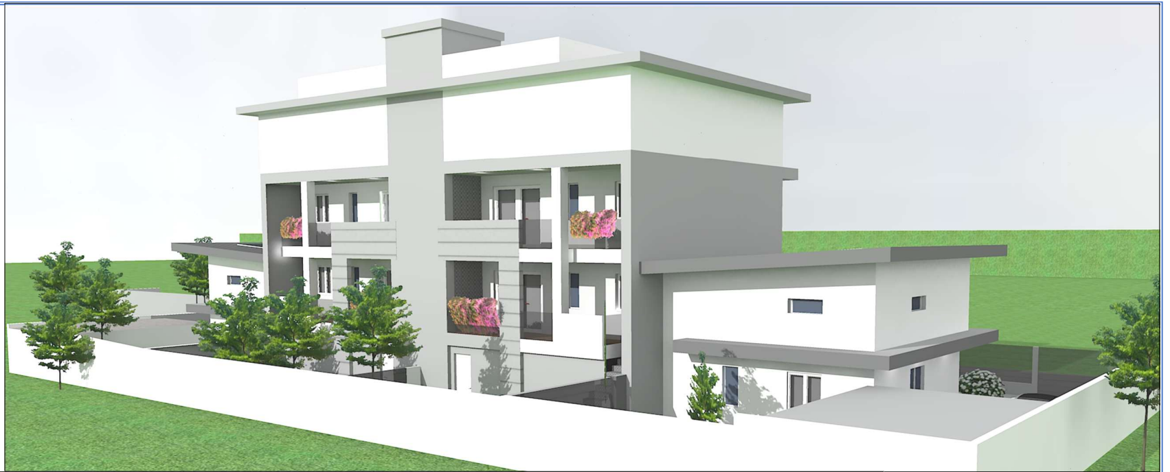
VISTA RETRO SUD/EST
